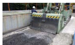
写真-2 施工状況
