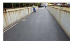
写真-3 施工完了
