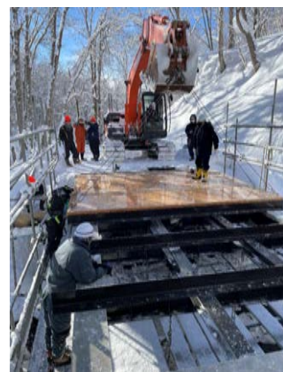
図6 CLT床版の架設
