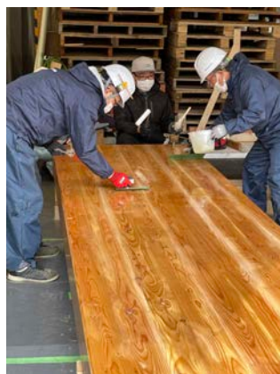
図5 CLTの防水処理
