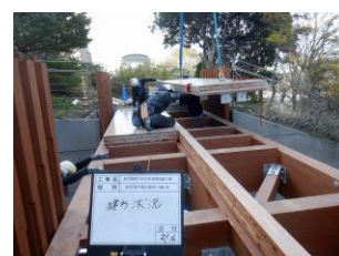
歩道橋（鹿児島県）
