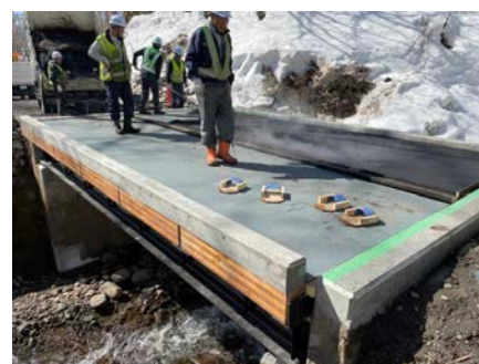
図8 アスファルト敷設
