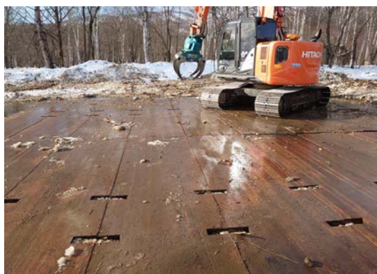
写真2 重機作業ヤードでの活用
