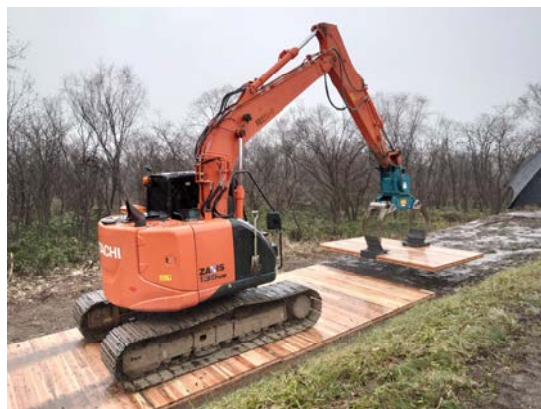
写真1 CLT 敷板の敷設
