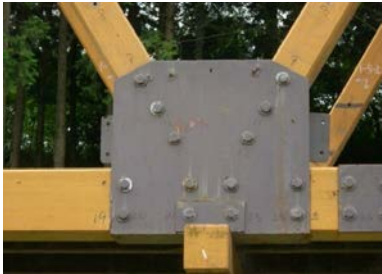
写真-3 トラス格点部
