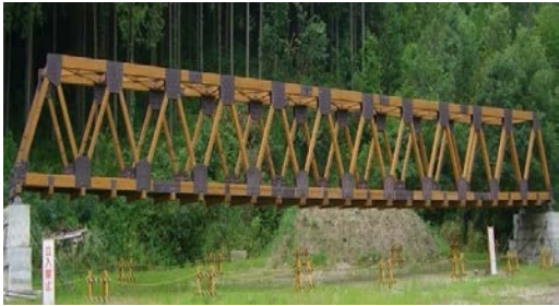
写真-1 対象橋梁の全映(第1径間)
