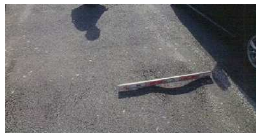
写真-2 簡易な路面段差の測定
