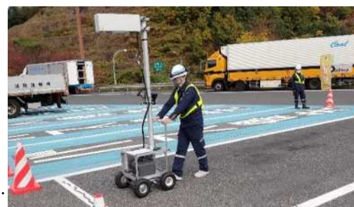
写真-3 路面性状測定実施状況
