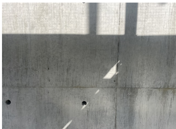
写真-4 止水テープ両側のみ
