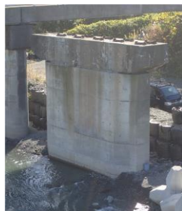
写真-2 対象橋脚
