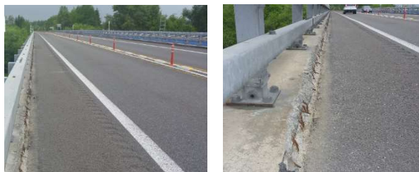
図-1 十勝川橋下り線地覆状況
