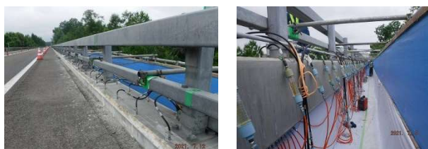
図-4 施工時の写真
