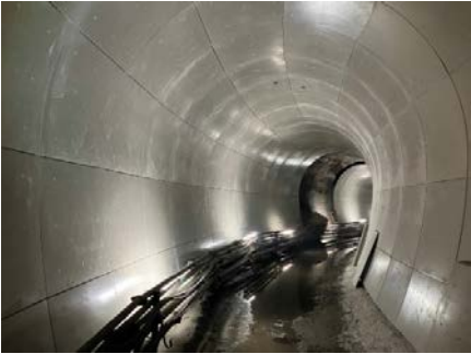
写真-2 パネル設置後(曲線部)
