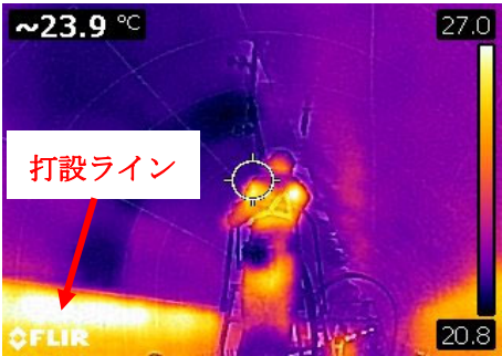
写真-3 サーモグラフィカメラによる打設高さ確認
