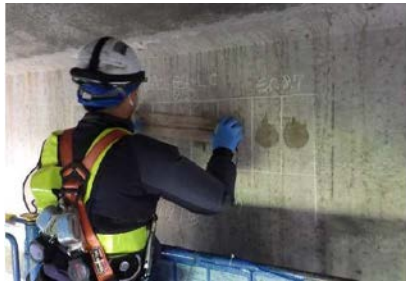
図-4 広帯域超音波法による調査状況
