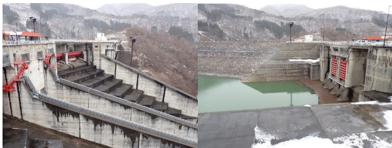
図1 洪水吐き全景その1
