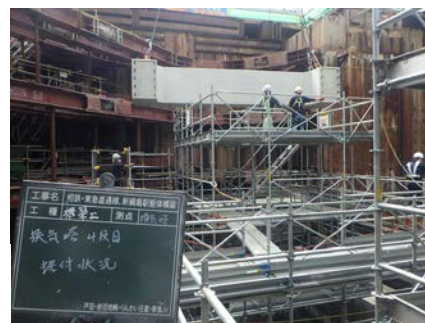
写真-1 プレキャスト部材据付状況
