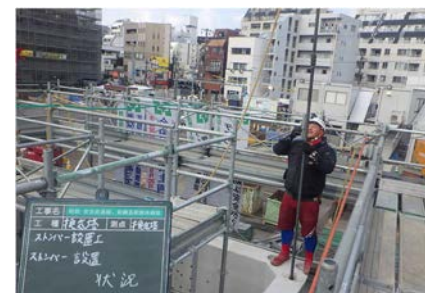
写真-2 ストンバー設置状況
