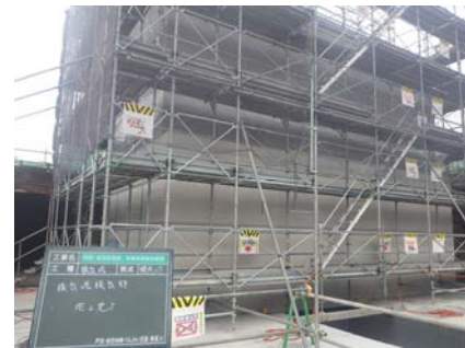
写真-4 換気塔構築完了
