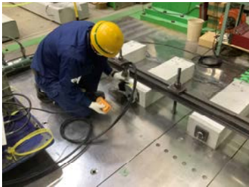
写真-2 締付け状況
