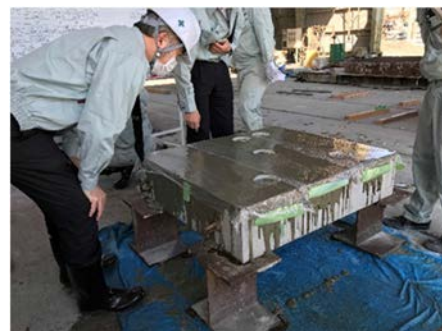
(無収縮モルタルの排出と密着確認)
