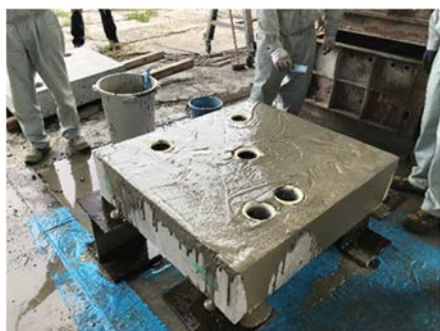
(無収縮モルタルの塗布)
