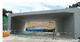
写真 1 大型ボックスカルバート
