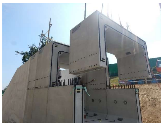
写真 3 2 分割ボックスカルバート施工状況 2
