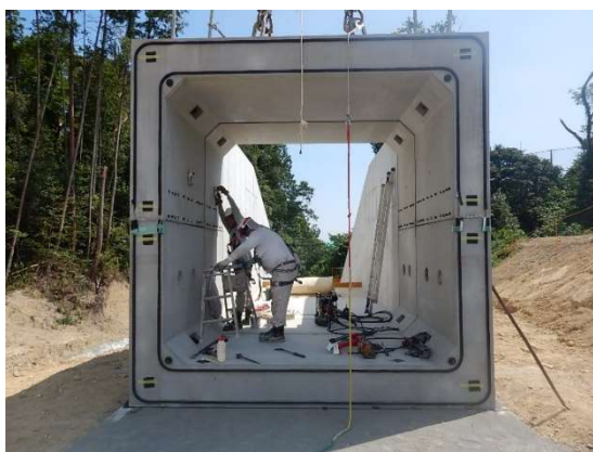
写真 2 2 分割ボックスカルバート施工状況 1
