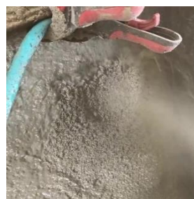
写真-7 垂直面吹き始め
