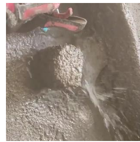
写真-8 垂直面吹き終り
