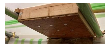
写真-6 天端の吹付面
