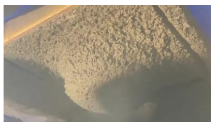
写真-9 吹付け状況 40% 20℃
