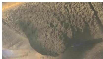
写真-10 吹付け状況 35% 15℃
