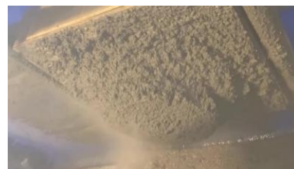
写真-8 吹付け状況 40% 15℃
