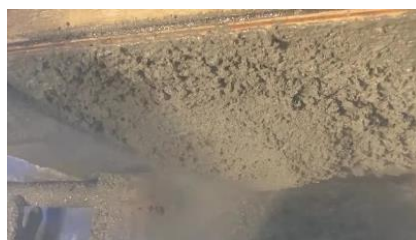
写真-7 吹付け状況 40% 10℃
