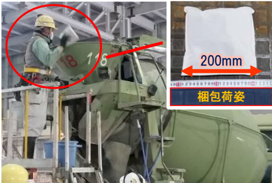
写真-2 粉末分散剤の投入状況
