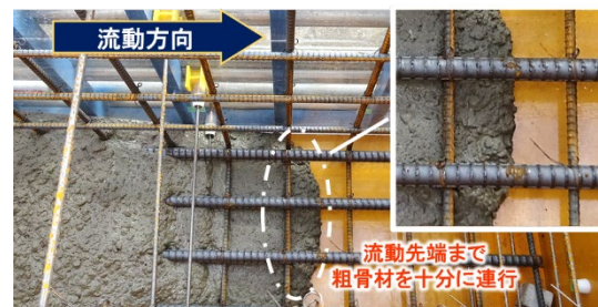
写真-1 流動先端状況
