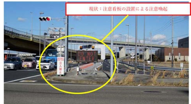
図-1 セントレア東 IC の現況
