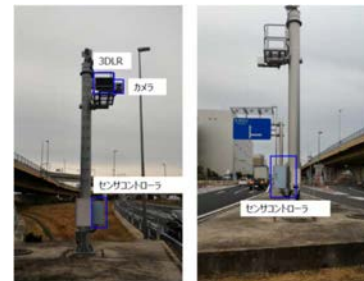
図-3 三次元レーザレーダの設置状況
