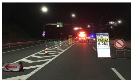
写真-2 夜間通行止め 実施状況
