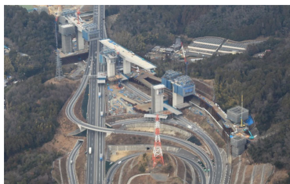
写真-4 現場状況写真
