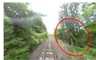
写真-2 線路側への傾倒木
