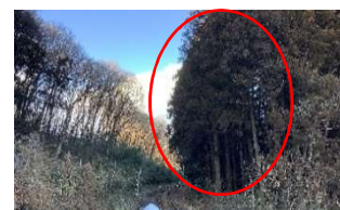
写真-3 建築限界への支障
