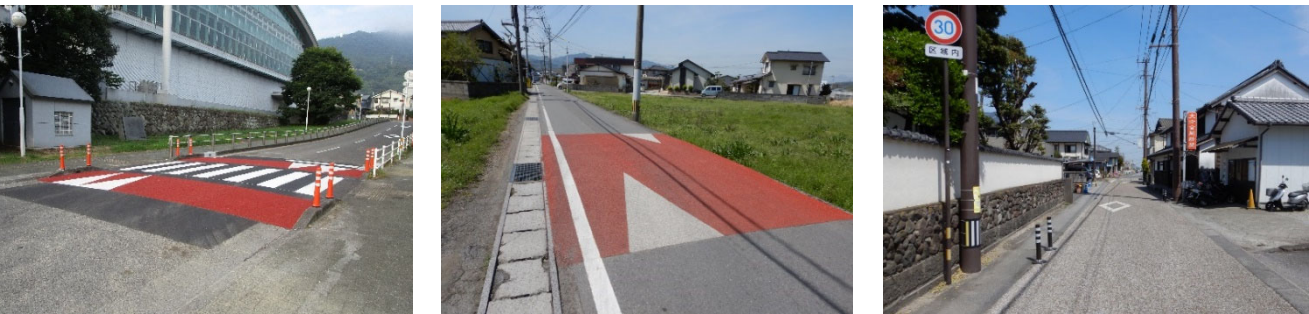
図-1 物理的デバイスの設置後の現地状況（左：スムーズ横断歩道，中：ハンプ，右：狭さく）
