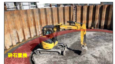
写真-1 地盤改良(碎石置換)
