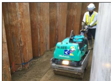
写真-2 底版部埋戻し
