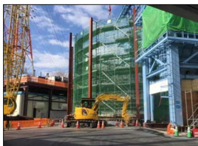
写真-5 沈設状況
