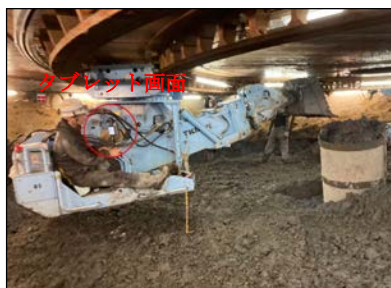
写真-6 有人掘削状況
