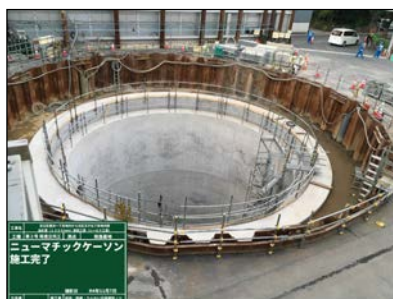
写真-7 沈設完了
