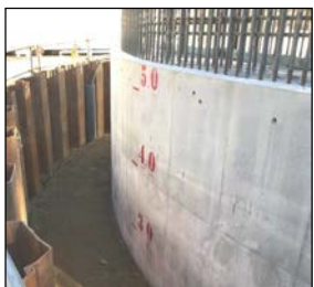
写真-2 底版部埋戻し
