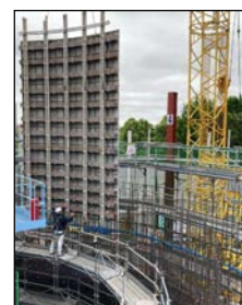
写真-4 大型枠組立
