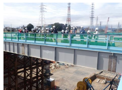
※仮設橋から掘削部を見学する様子
