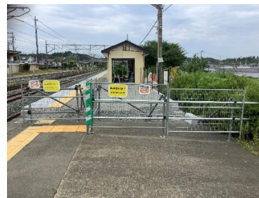
写真-3 仮復旧状況（改良範囲と改良範囲外の境界部）
