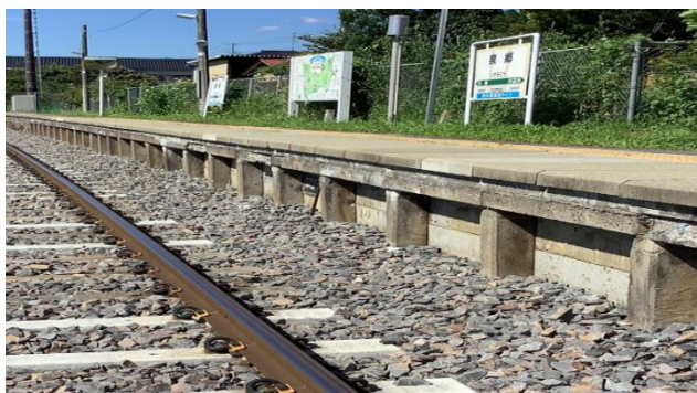
写真-1 組立式のホーム擁壁
