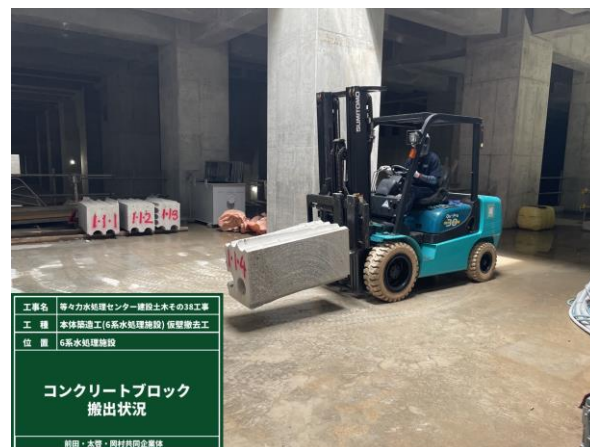
写真2 Co ブロック運搬状況
