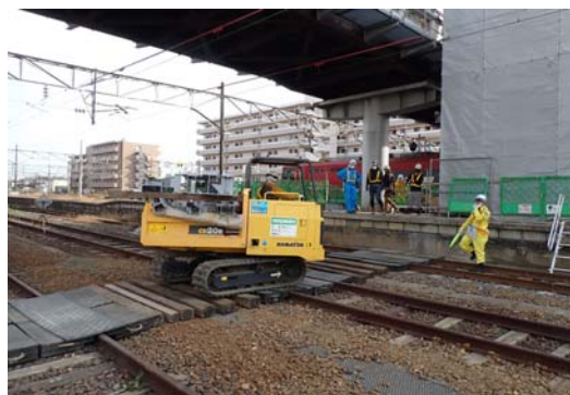
写真-1 重機による線路横断の運搬
