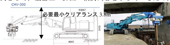
図-4 CHV 工法による施工イメージ 3)
