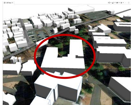
図-1 東洋大学川越キャンパス都市環境・建築実験棟
