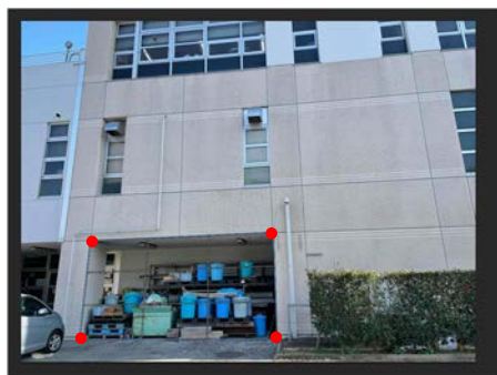
図-4 地上で撮影した都市環境・建築実験棟の側面写真
