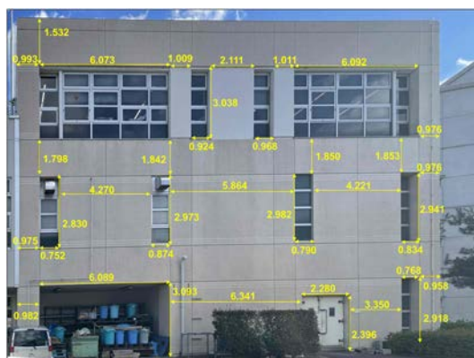
図-6 TS の対辺測量による建物の寸法の実測値
