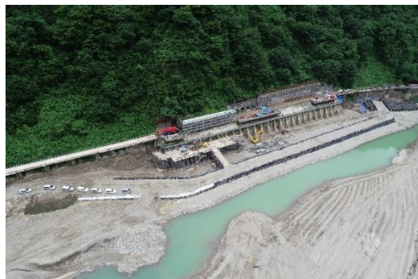
写真-4 仮締切完了 擁壁補強工事施工状況
