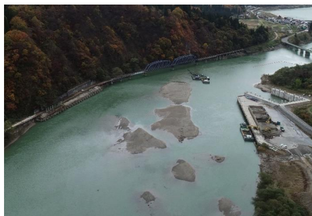
写真-2 台風による土砂流入
