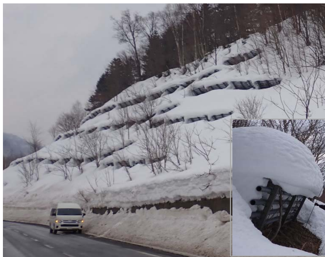
図-1 法面に設置された雪崩予防柵と雪底の発達事例
