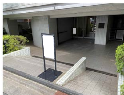
写真1 エントランスが掘り下げられたマンションの一例
