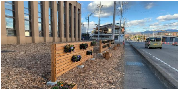
写真 2. 整備後の市役所前
