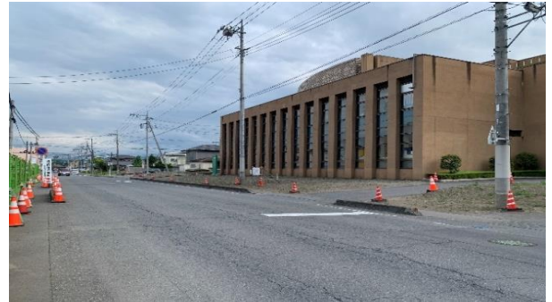
写真 1 安中市役所前(2022 年 5 月、筆者撮影) 不快感の緩和を図る。さらに市民参画の機会を設 を醸成するようなまちづくりを行うことが、「風景 を魅せるインフラ整備」の課題である。
