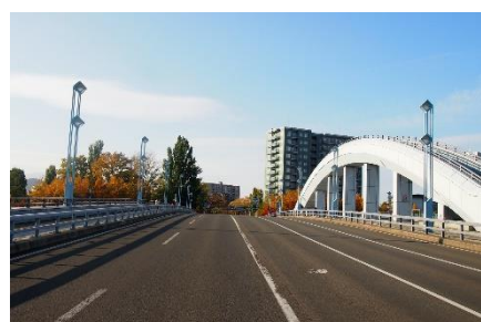
写真-1 幌平橋 橋上 (D/H>0.4)
