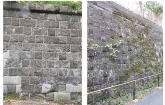
(1) 千代ヶ崎砲台（明治中期） (2) 汐入小学校（昭和初期） 写真-1 ブラフ積み擁壁
