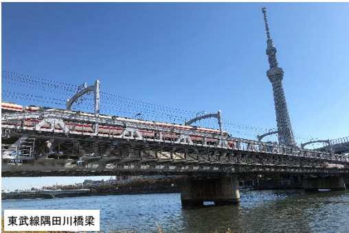
写真－1 中路ワーレントラスの事例
