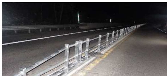
図3 センターパイプ設置状況
