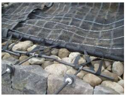
図-3 ジオグリッド 写真-3 ジオグリッド敷設状況
