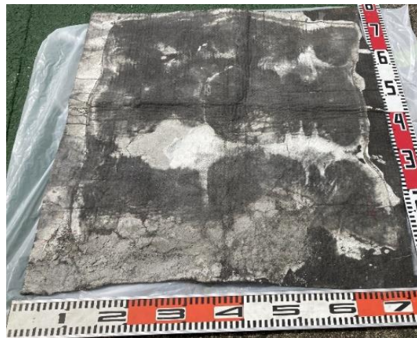
図-5 布製型枠施工時に付着したノロの様子
