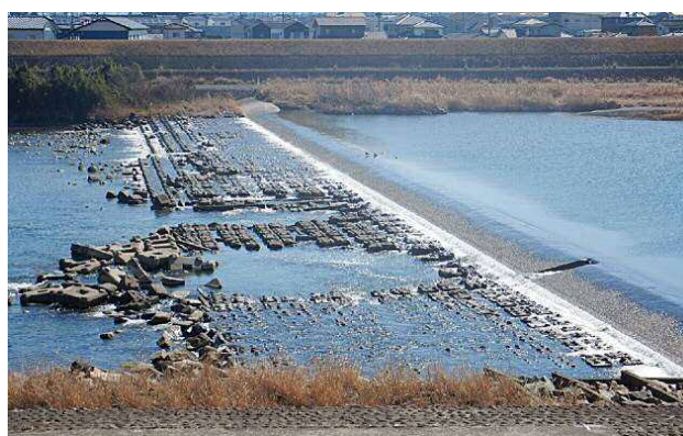
図-2 護床ブロックの局所的流出
