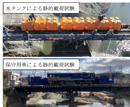
図-4 プレロード（静的載荷試験）状況
