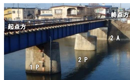
図-8 恒久復旧後状況
