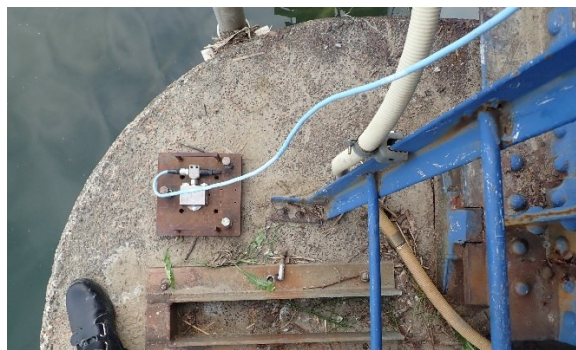
図3 実際の設置状況
