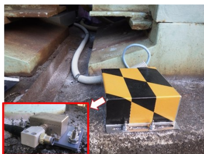
図4 センサ部の設置
