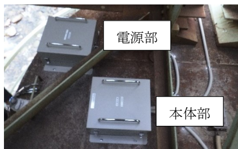
図5 本体部・電源部の設置
