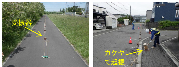
写真-1 表面波探査の測定状況
