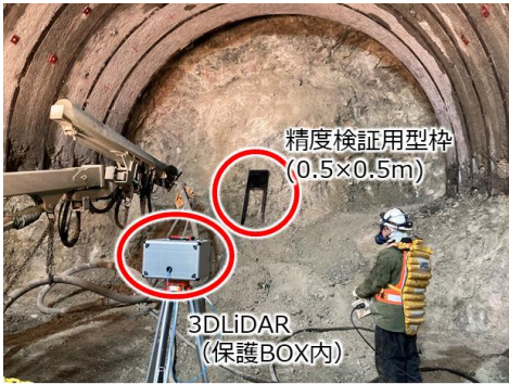
図-2 現場での精度検証試験状況
