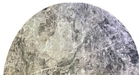
図1 画像処理前のトンネル切羽画像
