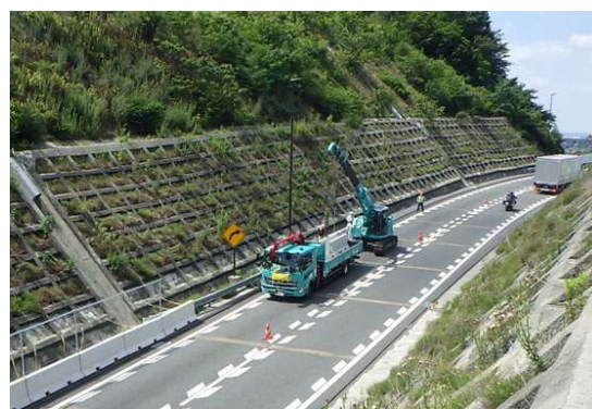
写真2 SRフェンス設置作業状況
