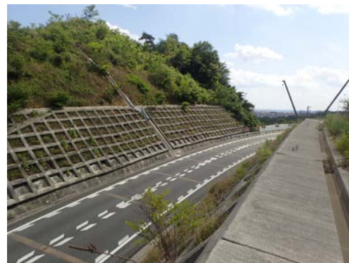
写真 1 切土施工予定切土のり面
