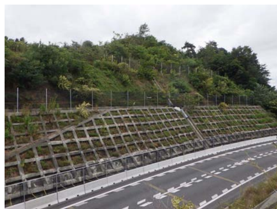
写真3 防護工設置完了後の現地状況
