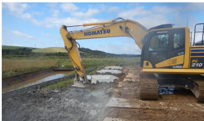
写真-1 地盤改良施工写真
